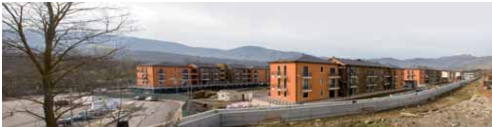
Realizzazione di 450 nuovi alloggi a Sassano zona Nsi
