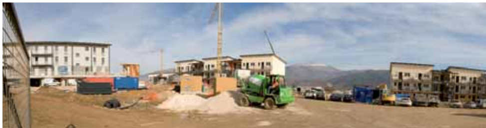
Realizzazione di 125 nuovi alloggi a Coppito 2
